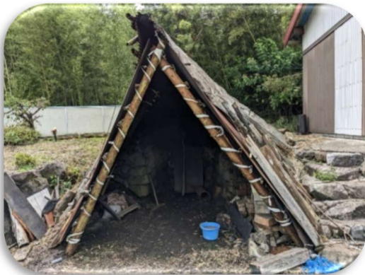
修繕後の炭窯
