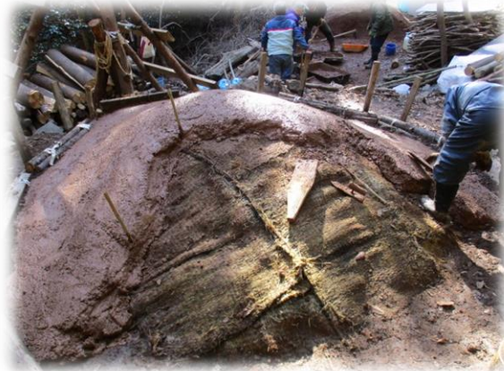
21日天井造りの様子
